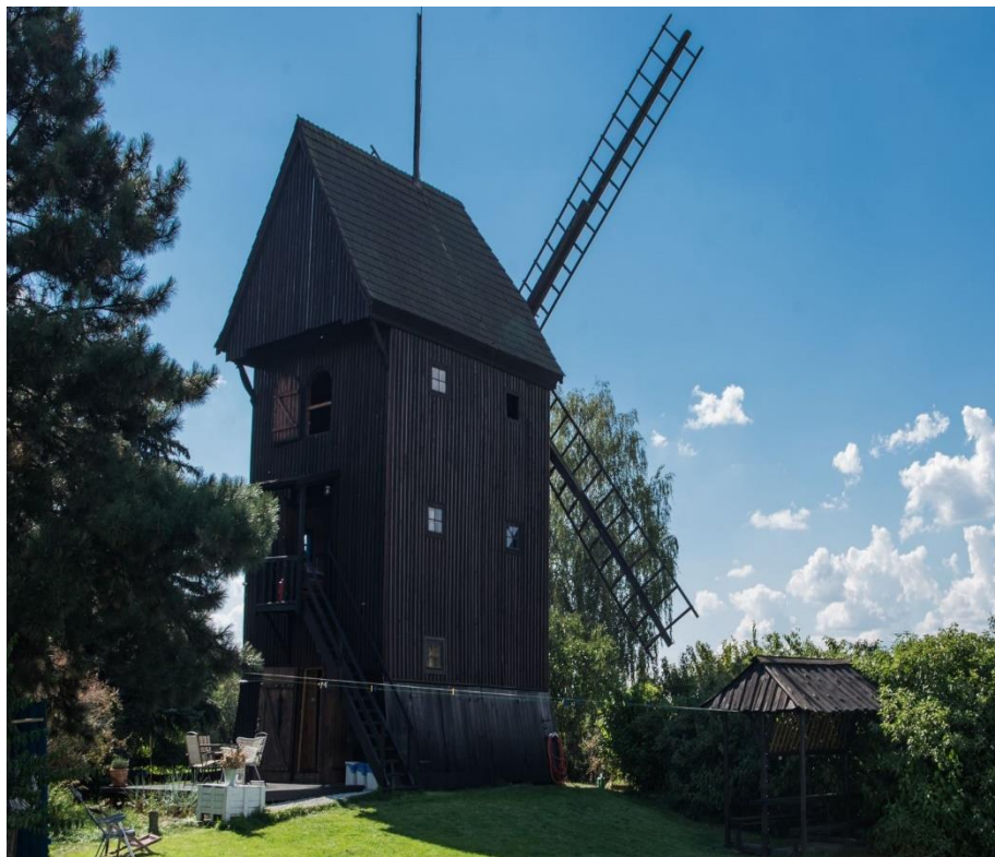
Na najwyższej kondygnacji zachowały się urządzenia do mielenia zboża.
